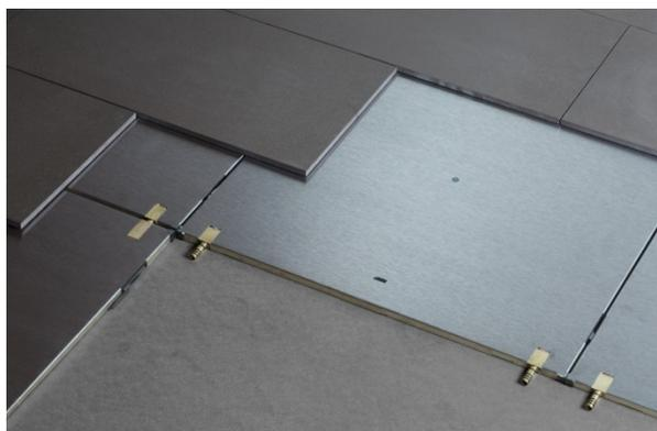
L'isolamento termico è conferito da uno strato di poliuretano da 150 Kg/m<sup>3</sup> di spessore 11 mm (5 mm in prossimità dei tubi) e un tappetino insonorizzante di compensazione in neoprene da 40 Kg/m<sup>3</sup> di spessore 2 mm con giunti di frazionamento in neoprene su ogni lato del modulo (ogni 60/120 cm).
